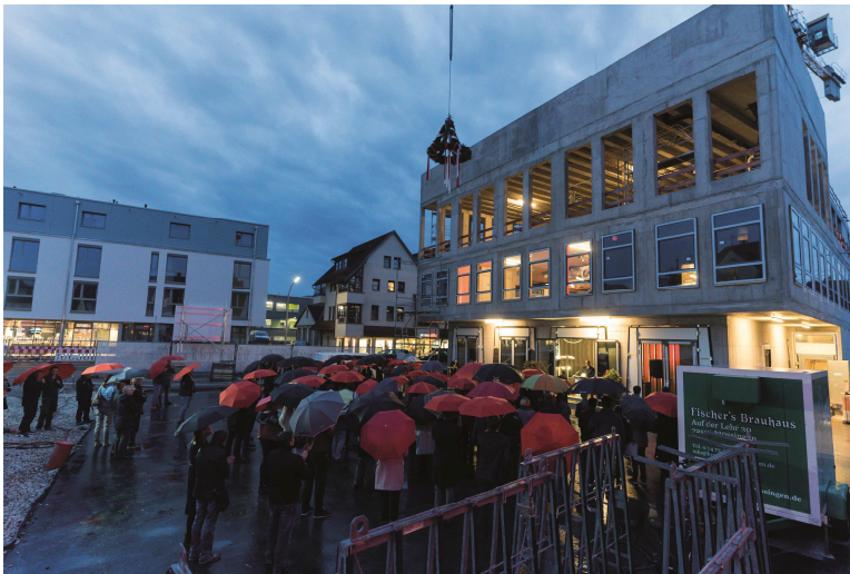
Fotonachweis „Richtfest“: Foto Keidel
