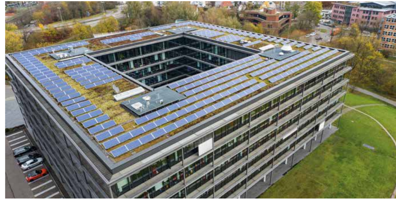
Die Photovoltaikanlage auf dem Dach des Sparkassen Carrés in Tübingen
